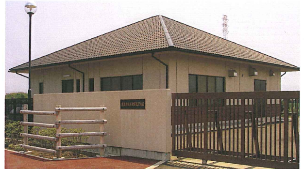
群馬県太田市般若地区の農業集落排水処理場にて同市と共同実証試験（平成18年12月より実施中）
